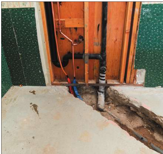
Устройство полов с подогревом от общедомовых систем горячего водоснабжения и (или) отопления.
