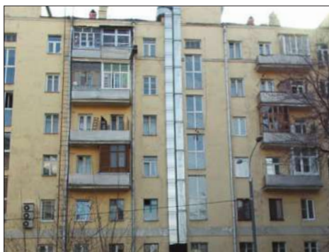
Устройство на фасаде многоквартирного дома вентиляционных коробов.
