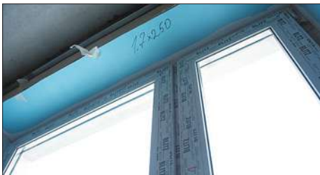
Замена окон без изменения оконного проема
