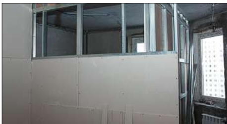
Монтаж и/или демонтаж несущих перегородок.
